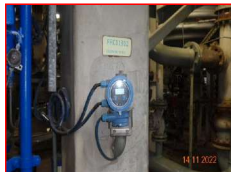
ภาพที่ 2.2-53 อุปกรณ์วัดค่าควบคุม (Transmitter)
