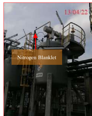
ภาพที่ 2.2-51 ระบบ Nitrogen Blanket
