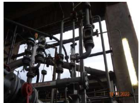
ภาพที่ 2.2-45 อุปกรณ์ระบายความดัน Pressure Relief Valve
