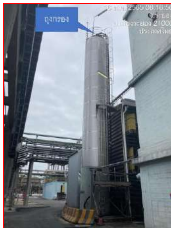
ภาพที่ 2.2-42 ถังกรองบริเวณถังเก็บกัก ผง Carbon Black
