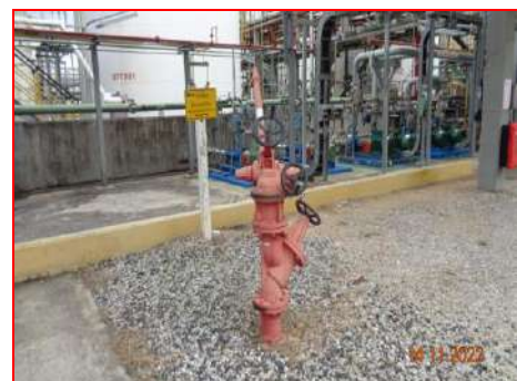
ปืนฉีดน้ำดับเพลิงชนิดติดตั้งประจำที่
