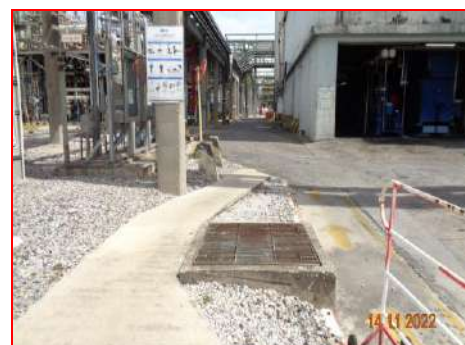
ภาพที่ 2.2-16 รางระบายน้ำฝนนอกพื้นที่ กระบวนการผลิต
