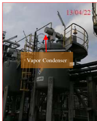
ภาพที่ 2.2-52 ระบบ Vapor Condenser ถังเก็บกักตัวแรงปฏิบัติการ
