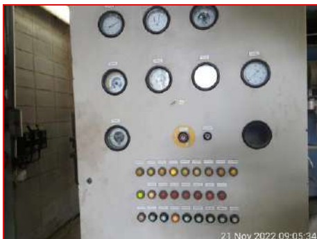
ภาพที่ 2.2-7 แผงควบคุมปริมาณน้ำมัน (Local Panel)
