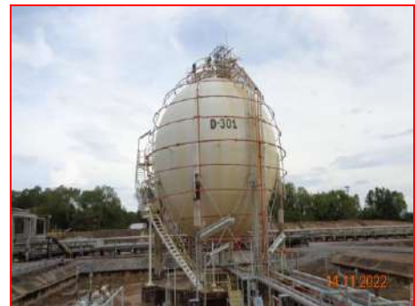
ถังเก็บบิวทีน-1 (D-301) ภาพที่ 2.2-43 Fire Water Spray ของเขต ประกอบการอุตสาหกรรมไออาร์พีซี
