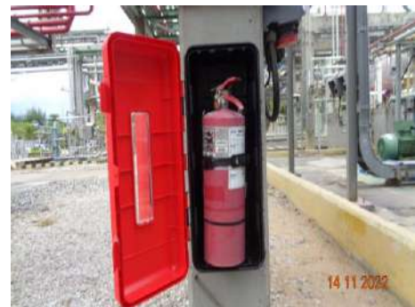
ถังดับเพลิงเคมีแห้งชนิดมือถือ
