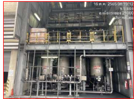
ภาพที่ 2.2-41 ระบบ Dumping Station ของ Carbon Black
