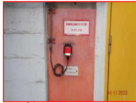
ภาพที่ 2.2-47 ระบบหยุดแบบฉุกเฉิน (Emergency Shutdown)
